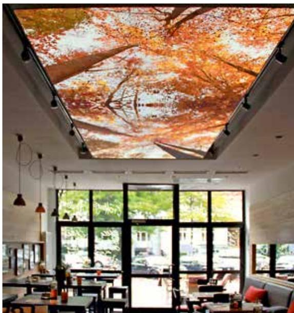
*Ein solches Spannleuchtdecken-Element mit seitlicher Lichteinstrahlung bei homogener und gleichmäßiger Motivausleuchtung öffnet einen Raum z.B. geschickt nach oben ... (Foto: Architekten Kaufmann Focke, Hamburg)*
